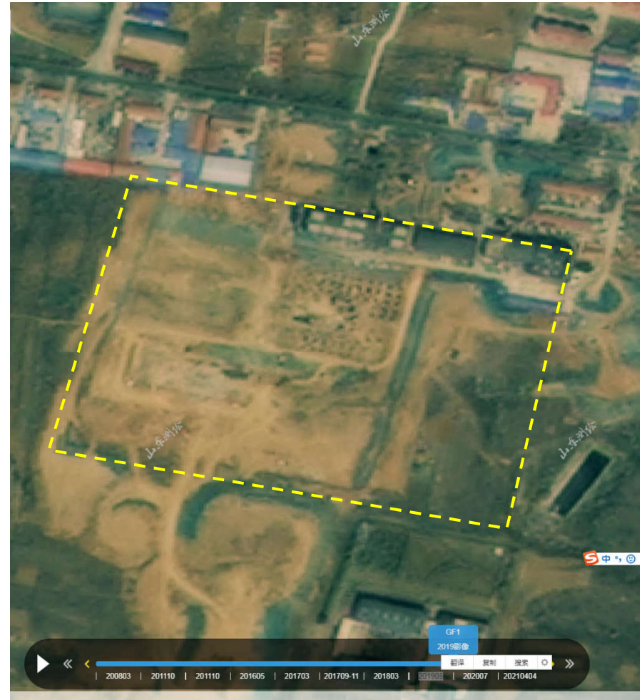
工程施工期影像（2019年5月）
